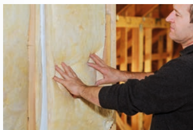
Lana de roca / lana de vidrio es irritante, suelta par- tículas y absorbe la humedad provocando mohos
